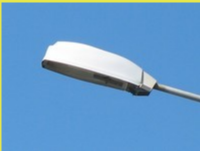
Lanterne à appareillage incorporé. Apparue en 1973
