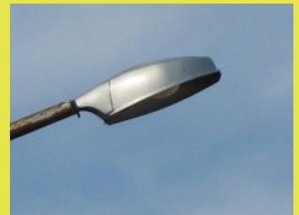
Lanterne à appareillage non incorporé. Apparue en 1969
