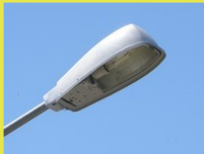
Lanterne à appareillage incorporé. Apparue en 1971
